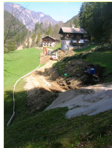
Bauarbeiten im Bereich „Wies“
