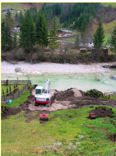
Bohrarbeiten bei Achenquerung im Innerort
